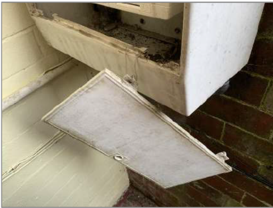
Photo - 109 Broken meter box door
